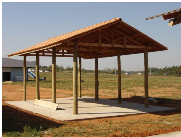
Figura 02 – Sistema estrutural em pilar roliço e treliça
